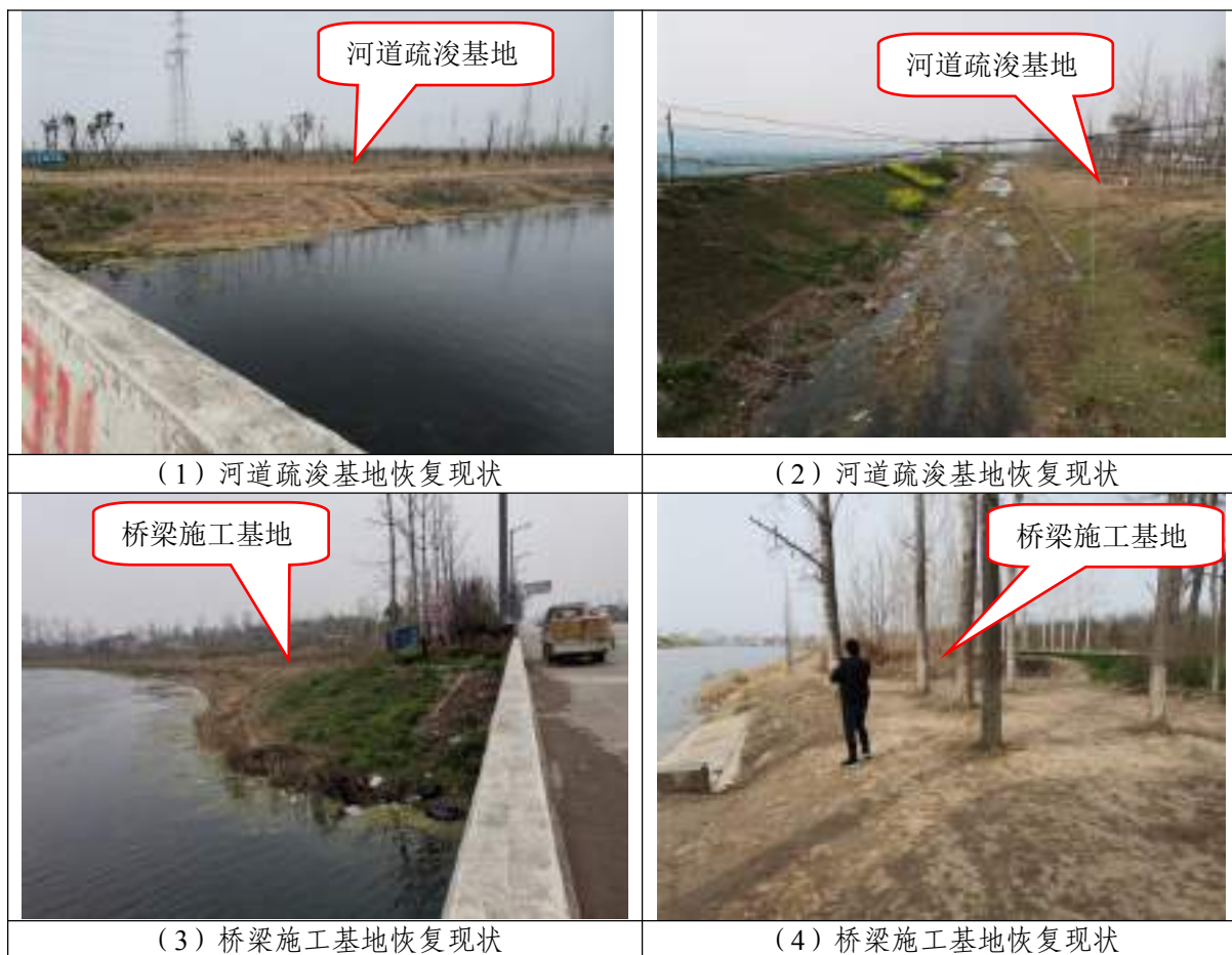
图 1-2 施工生产区恢复现状影像图
