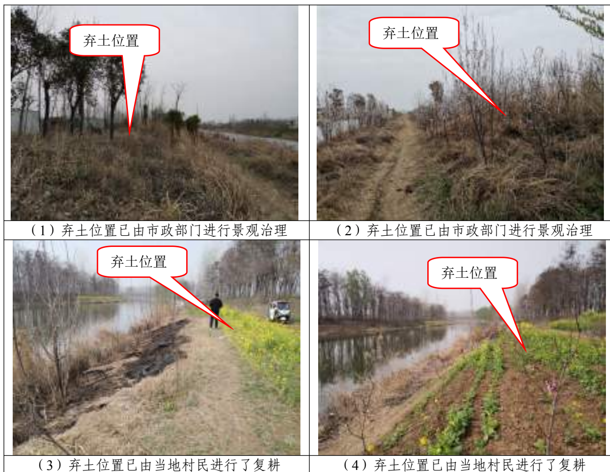
图 1-1 项目弃土场现状影像图
