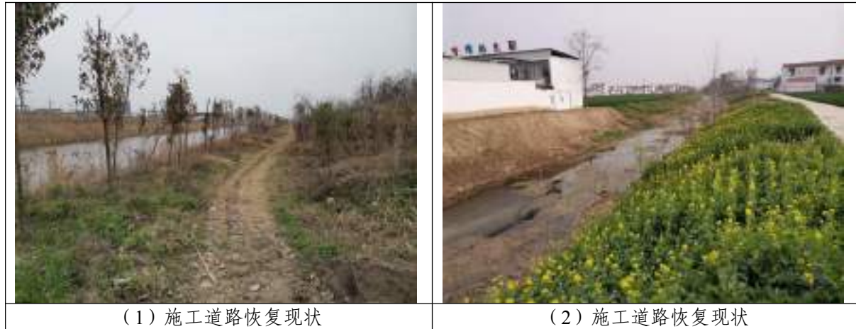
图 1-3 施工道路恢复现状影像图
